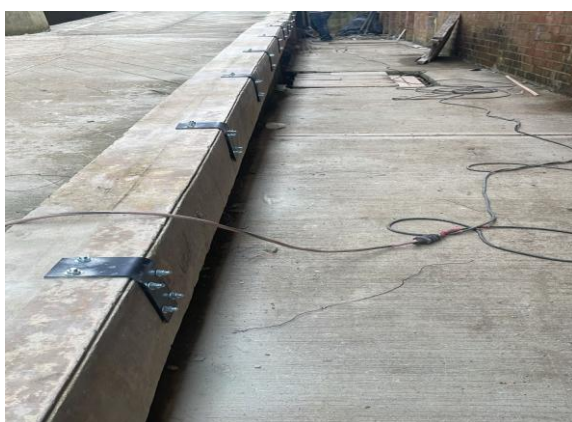
Instalación de carpintería metálica – Pasamanos en pasillos y rampas
