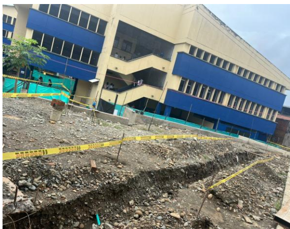
Excavación e instalación de tubería red contra incendios
