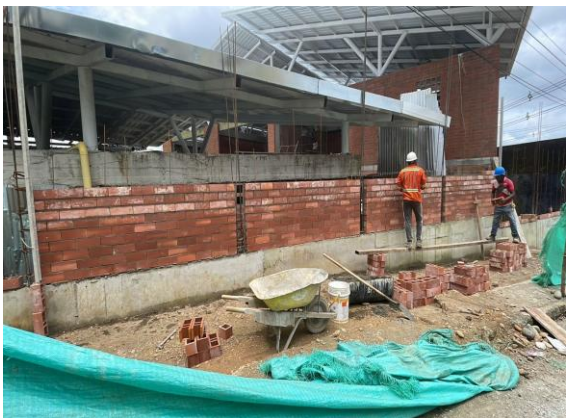
Construcción muro de cerramiento perimetral
