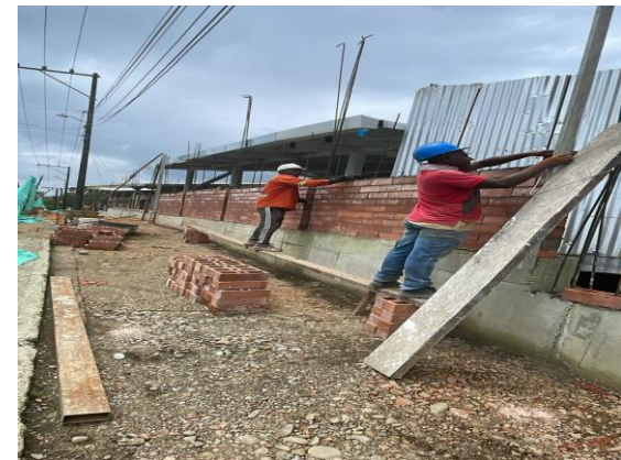
Construcción muro de cerramiento perimetral
