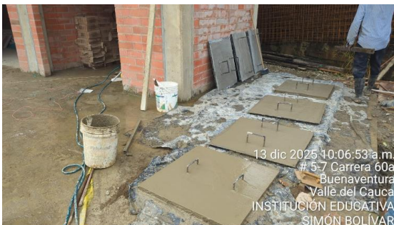
Instalación de cajas de Inspección e instalaciones eléctricas
