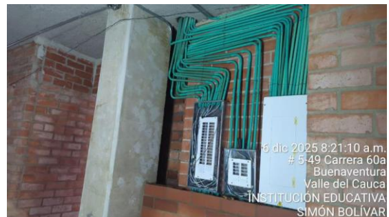
Instalación de cajas de Inspección e instalaciones eléctricas
