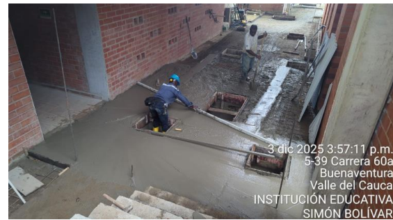
Excavación y fundición de andenes
