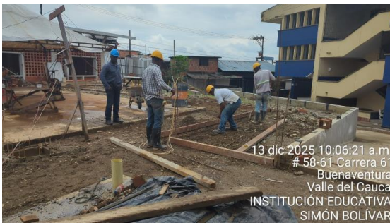
Excavación y fundición de andenes
